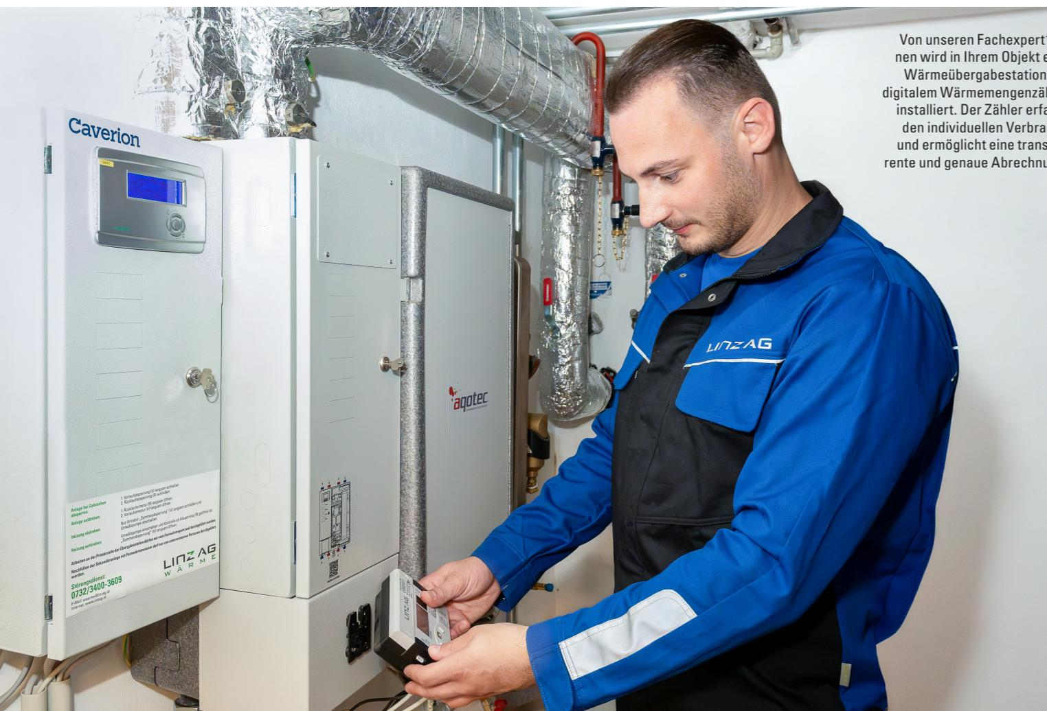
Von unseren Fachexpert\*innen wird in Ihrem Objekt eine Wärmeübergabestation mit digitalem Wärmemengenzähler installiert. Der Zähler erfasst den individuellen Verbrauch und ermöglicht eine transparente und genaue Abrechnung.
