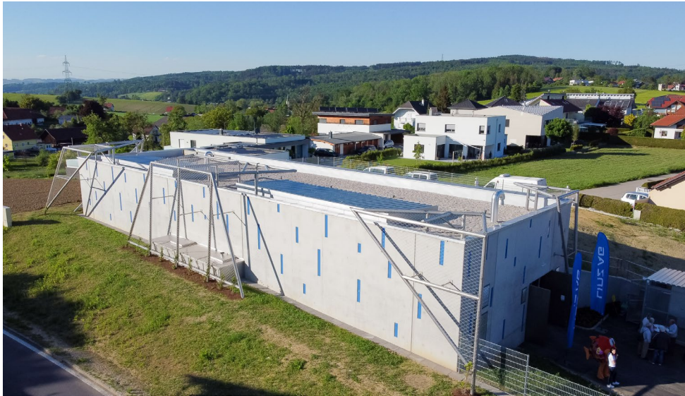
Bildtext: Außenansicht vom neuen Hochbehälter Hitzing.
