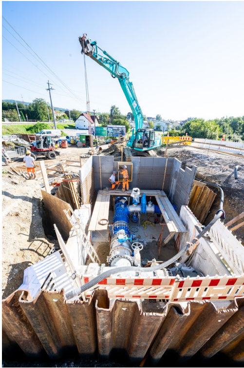
Bildtext: Einbindungsarbeiten des Druckreduzierungsschachtes in Pasching im Mai 2020.
