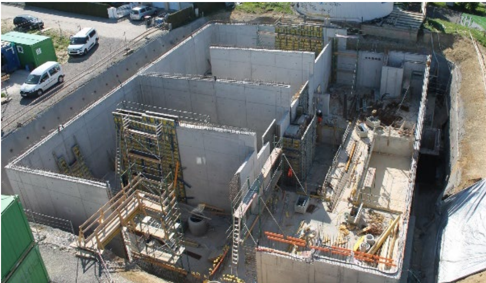
Bildtext: Die Behälterkammern und der Rohrkeller im April 2020.
