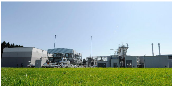
Abb.: Erdgasspeicher 7fields/Zagling
