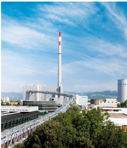
Abb.: 460 Meter langer Rohrgurtförderer (l.) zwischen RABA (r.) und RHKW im Kraftwerkspark Linz-Mitte (l.). © LINZ AG (l.), LINZ AG/Rudi Kremair (r.)
