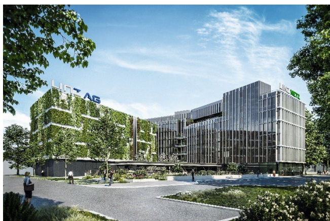
Abb.: Das neue Netzgebäude der LINZ NETZ GmbH. (Fotocredit: ZOOM VP.AT)
