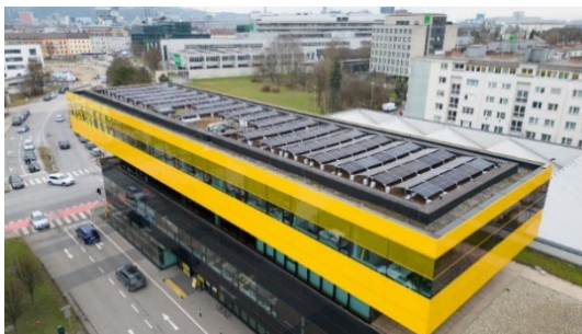
Bild : Neue PV-Anlage am Dach des ÖAMTC Oberösterreich-Stützpunkts, Wanklmüllerhofstraße, Linz (Fotocredit: LINZ AG/Fotokerschi)
