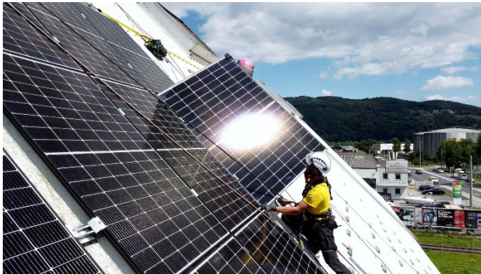
Abb.: Aufgrund der Schräglage des Daches musste die PV-Anlage am Fernheizkraftwerk Mitte von Industriekletterern montiert werden. (Foto-credit: LINZ AG/Hofer)
