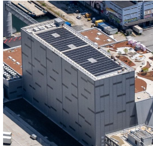
Abb.: PV-Anlage am Dach der neuen TK- und Pharmahalle im LINZ AG HAFEN. (Fotocredit: Pertlwieser)
