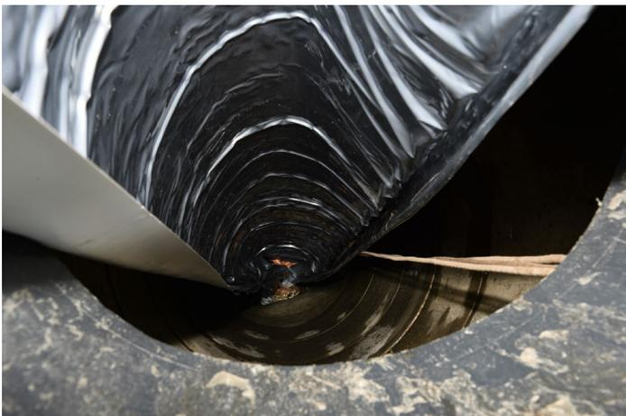
**Bildtext:** Innovative Kanalsanierung durch „Schlauchlining“
