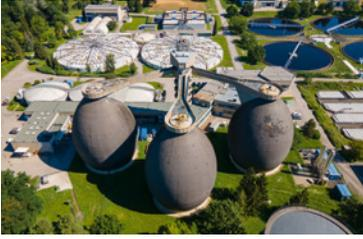
*In der Regionalkläranlage Asten wird das Abwasser mechanisch und biologisch gereinigt. Dabei fallen jährlich 7 bis 8 Mio. Kubikmeter Faulgas (= Biogas; im Bild vorn die Faulbehälter) an. Das Biogas wird auf Erdgasqualität gereinigt und entweder in das Gasnetz eingespeist oder vor Ort verstromt, wobei die dabei anfallende Abwärme in das Biowärmenetz Asten eingespeist wird.*
