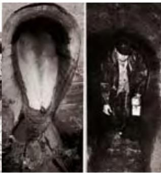
Automatische Reinigung nach dem Rückstoßprinzip: Ab den 1970ern reinigen Hochdruckdüsen die Linzer Kanäle. Dann erst müssen die Arbeiter zur Begehung in die Tiefe.
