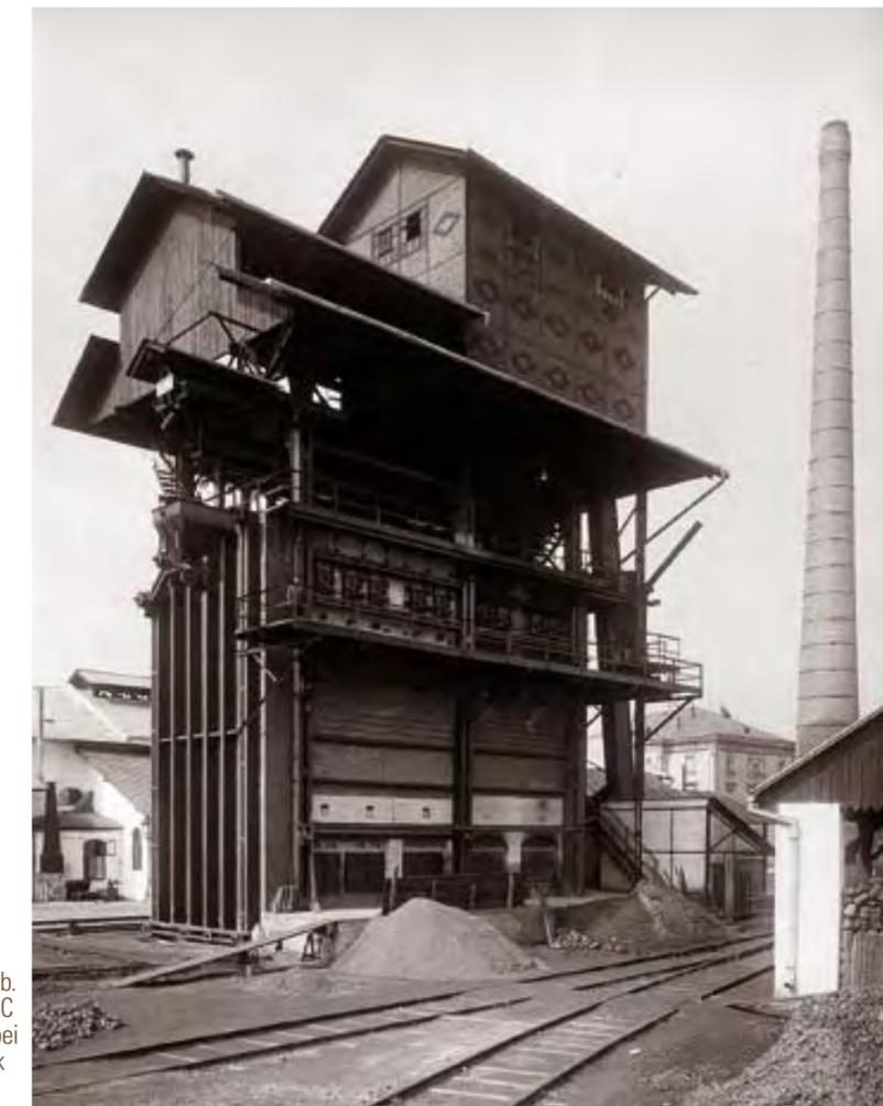
Das Linzer Gaswerk an der Kaplanhofstraße in den 1920ern – von 1858 bis 1957 ist es in Betrieb. Zur Gaszerzeugung wird Steinkohle in den 1.200° C heißen Öfen unter Luftabschluss erhitzt und dabei entgast. Dabei entstehen auch Teer, Ammoniak und Koks.
