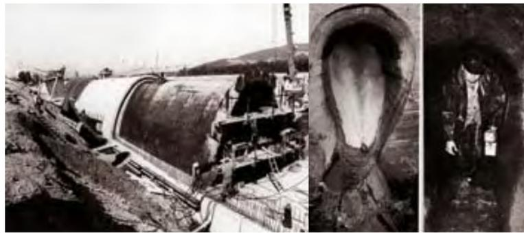
Bau des Umleitungskanals: Ab 1979 leitet der 12 km lange Kanal die Abwässer aus Stadt und Umland im freien Gefälle zur Regionalkläranlage Asten. (AS/IL)
