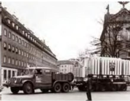
Transport eines 110-kV-Blocktransformators zum Umspannwerk Linz-Nord im Jahr 1965.
