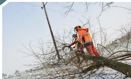
Die Profis der LINZ NETZ GmbH halten Stromleitungen von Ästen und Zweigen frei.
