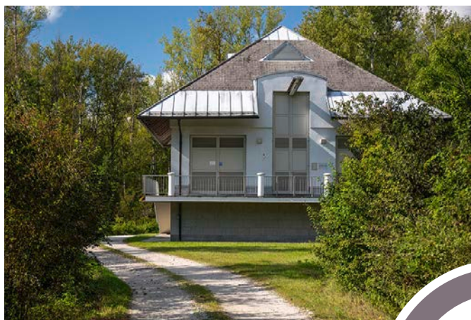
Das bestehende Wasserwerk Goldwörth, eingebettet in die Natur.
