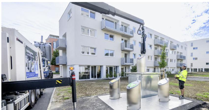
Die Entleerung der Behälter funktioniert mit einem speziellen Kransystem.
