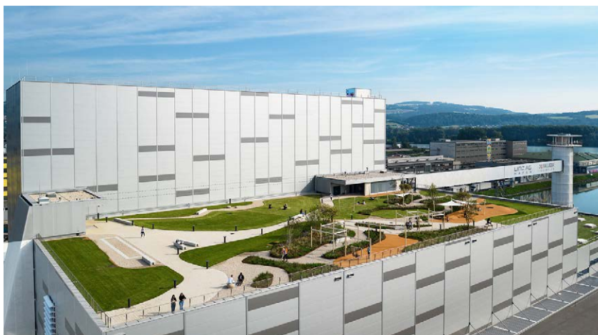
Auf dem Dach der Tiefkühl- und Pharmahalle im Linzer Hafen befindet sich ein Freizeitareal mit Hängematten, Sitzbänken, Schaukeln und vielem mehr.
