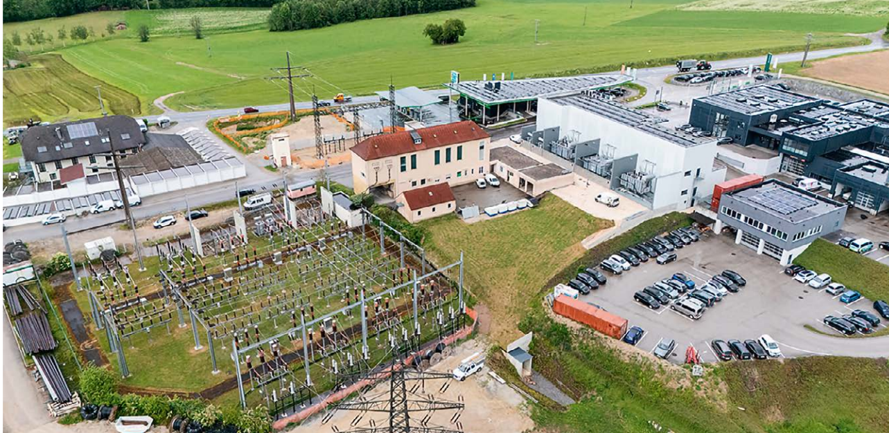
Das Umspannwerk Friensdorf im östlichen Mühlviertel wurde Anfang Juli mit doppelter Leistung in Betrieb genommen.
