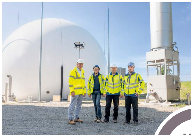
Ein Team der Regionalkläranlage Asten vor der neuen Anlage.
