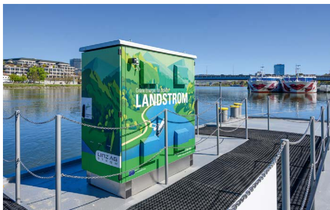
Der neue Landstrom-Energieterminal versorgt Donau-Kreuzfahrtschiffe umweltfreundlich mit Energie.
