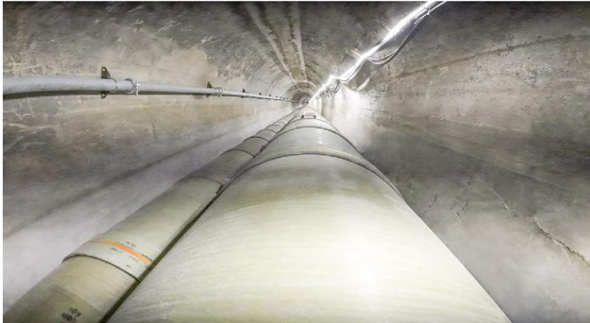
**Der Düker ist vier Meter breit, 5,5 Meter hoch und 1,35 Kilometer lang. In rund 30 Metern Tiefe wird er aktuell aufwendig saniert.**
