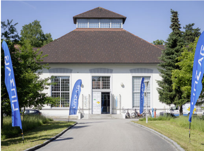
Das Wasserwerk Scharlinz öffnet am 14. Juni 2024 ab 14 Uhr seine Pforten. Wasserwerkstraße 2, 4030 Linz
