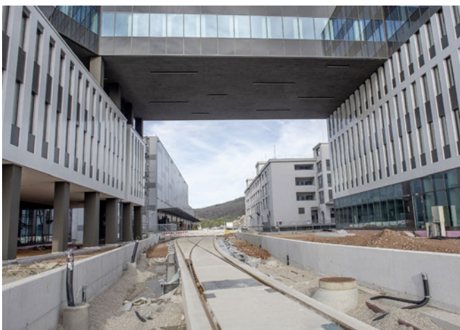
Die neue Gleisgruppe während der Bauarbeiten im April 2024. Links hinten ist die Tiefkühl- und Pharmahalle zu sehen.
