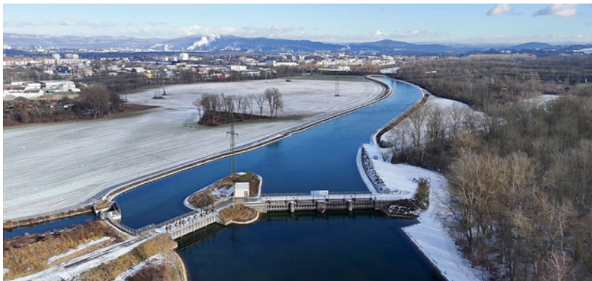
Der 2,8 km lange Oberwasserkanal leitet das Wasser der Traun zum Wasserkraftwerk Kleinmünchen.
