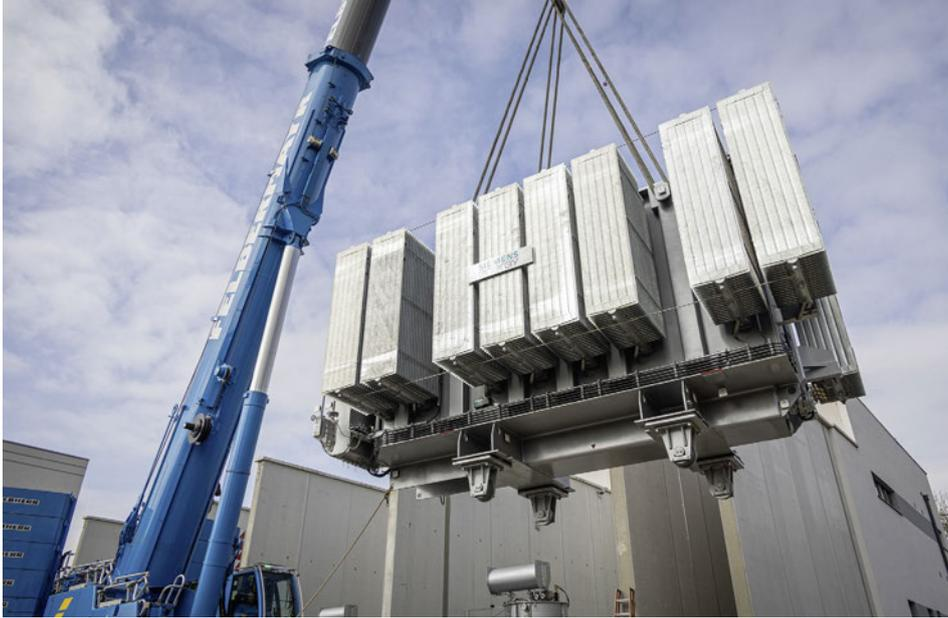
Die LINZ NETZ GmbH legte den Fokus 2022 neben dem Anschluss von PV-Anlagen vor allem auch auf die Netzstärkung, etwa durch die Installation von neuen Transformatoren in Umspannwerken.
