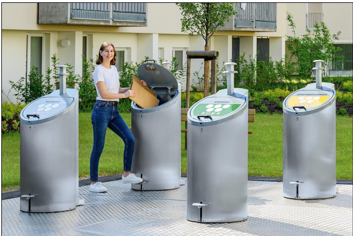
Abb. 18: Unterflursysteme in Linz
