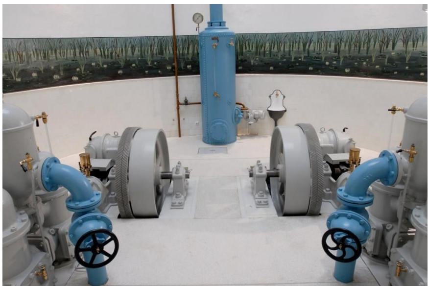
Abb. Blick in den Keller des sanierten historischen Brunnens im Wasserwerk Heilham, 2008
