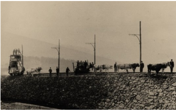
Bildtext: 1897 beim Bau der Pöstlingbergbahn: Für den Transport der Geräte dienten Ochsespanne.
