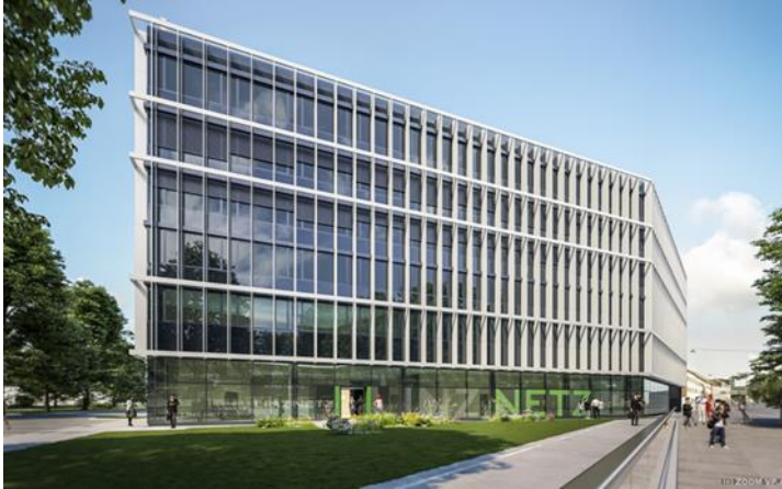
Abb.: Ansicht des neuen Netzgebäudes (Strom- und Gasnetz-zentrale) „Sektor Wiener Straße“
