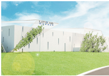
Neubau des Hochbehälters in Hitzing – zur langfristigen Sicherung der Wasserversorgung
