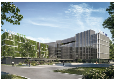
Erweiterung LINZ AG-Center – Neues Netzgebäude an der Wiener Straße
