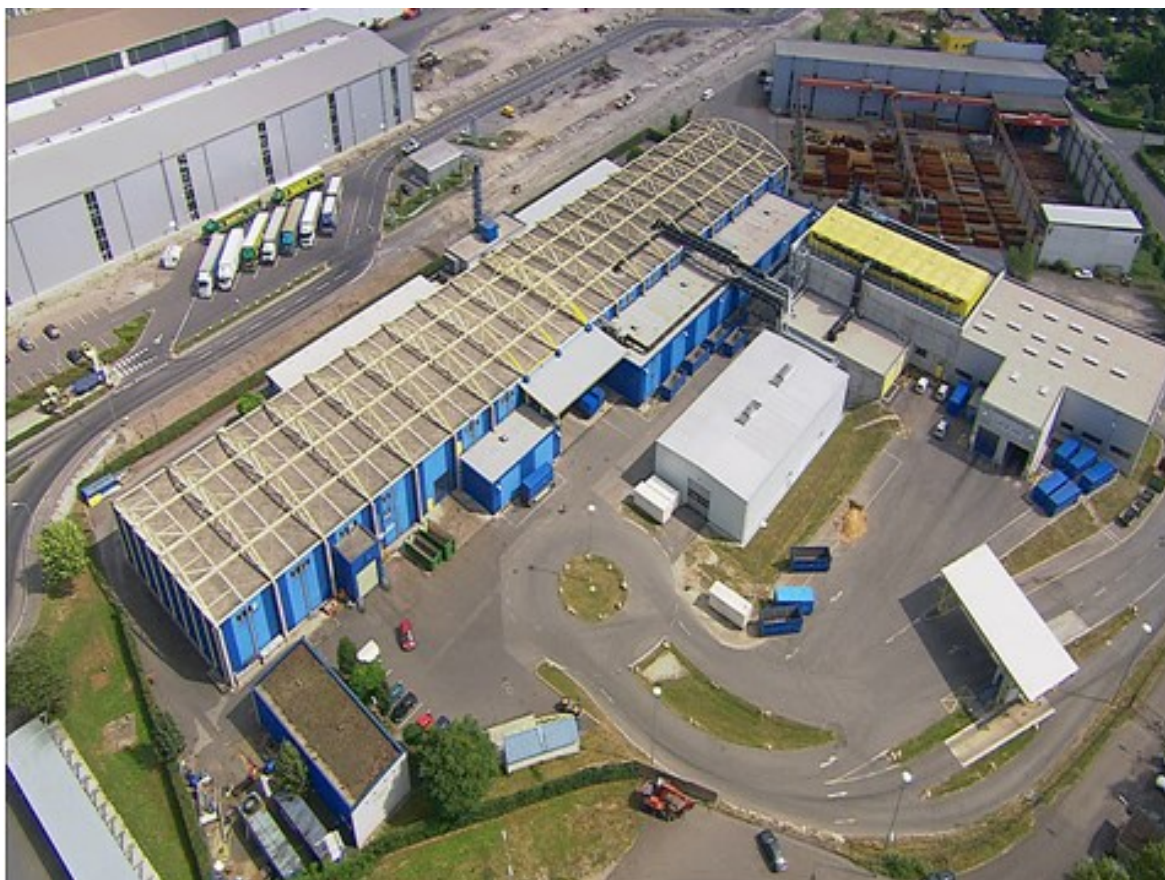
Abb. 78: MBA und Kompostanlage der LINZ AG in der Gaisbergerstraße
