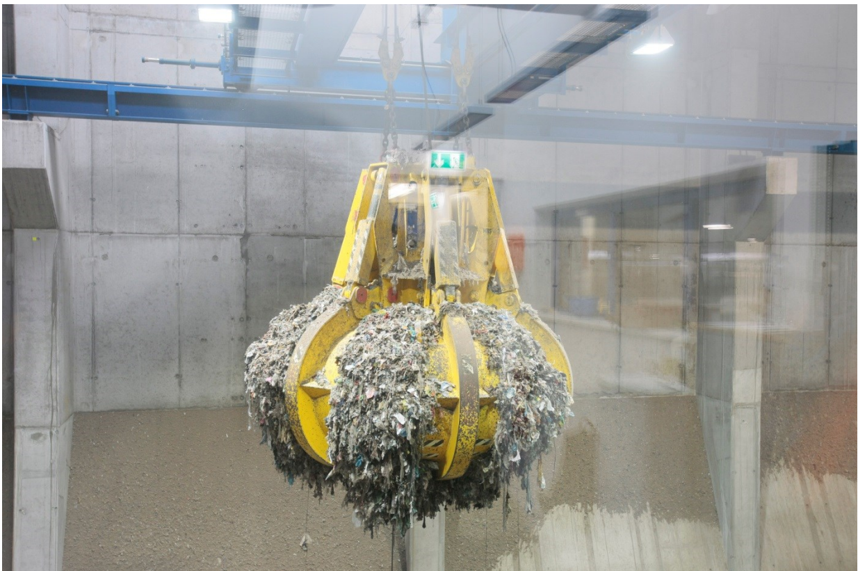
Abb. 77: Greifer im Bunker
